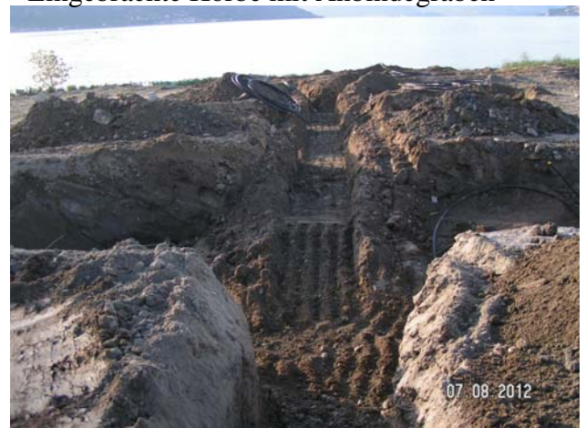
Eingebrachte Körbe mit Anbindegraben
